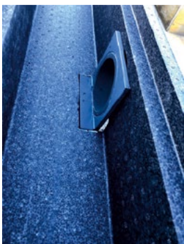
6. Abläufe und Blech montieren
