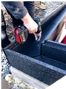
4. Steine auf Betonkrone befestigen
