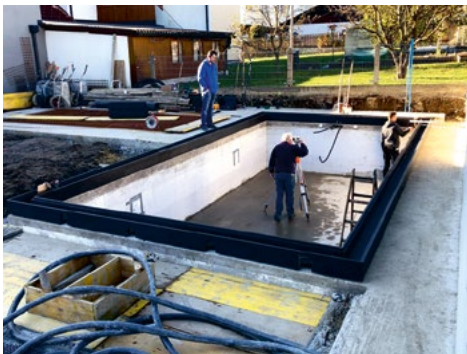
3. Mit Stellfüßen nivellieren und ausrichten
